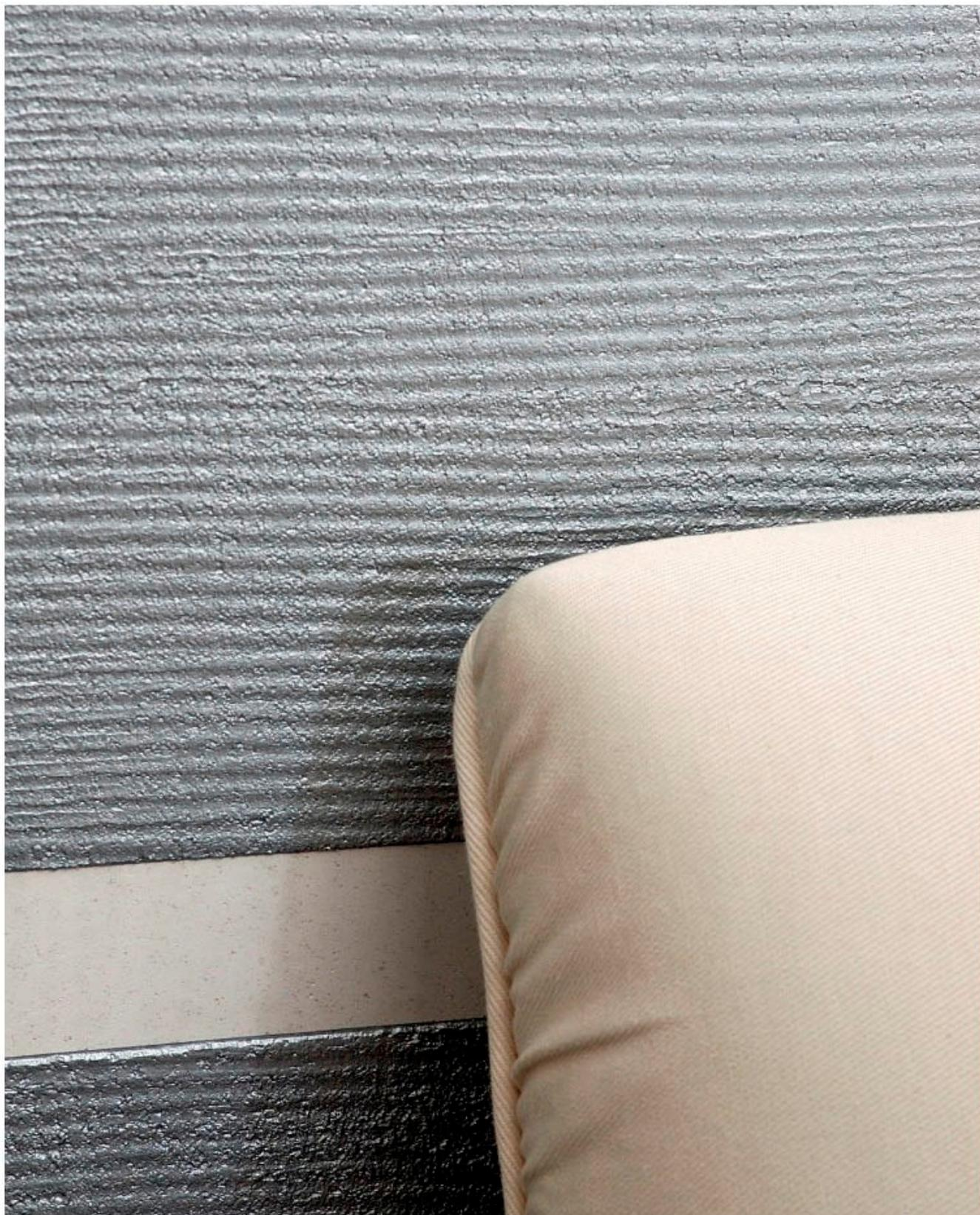
L'ingrandimento della lavorazione permette di apprezzare la tecnica utilizzata evidenziando il contrasto materico tra la rigatura in rilievo argento e le fasce levigate del marmorino. Una particolare texture ad effetto tattile accentuato dal naturale calore dei materiali a calce. **MARCO ZANIBONI - WALL TEXTURE.**
